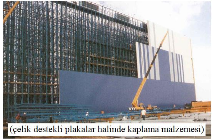
Şekil 2.3. Rijit yapılı poliüretan örnekleri (Grünbauer vd., 2004)
