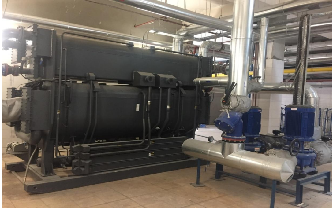
Şekil 3.15 Hastaneden kullanılan 675 kW gücündeki Absorbsiyonlu soğutucu
