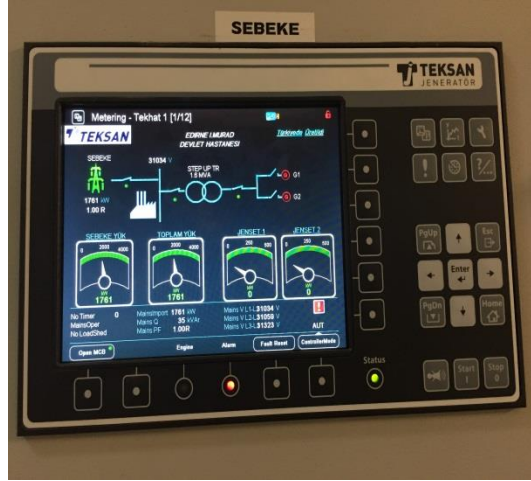
Şekil 3.21 Comap marka IntelliVision8 model dijital kontrol ekranı.
