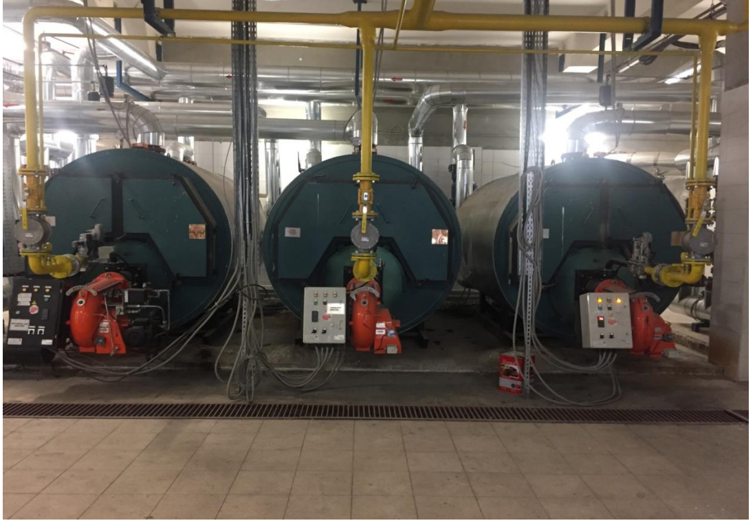
Şekil 3.3 Hastane ısınma ihtiyacını karşılayan 3 adet 2.500 kW gücündeki doğal gaz kazanları.
