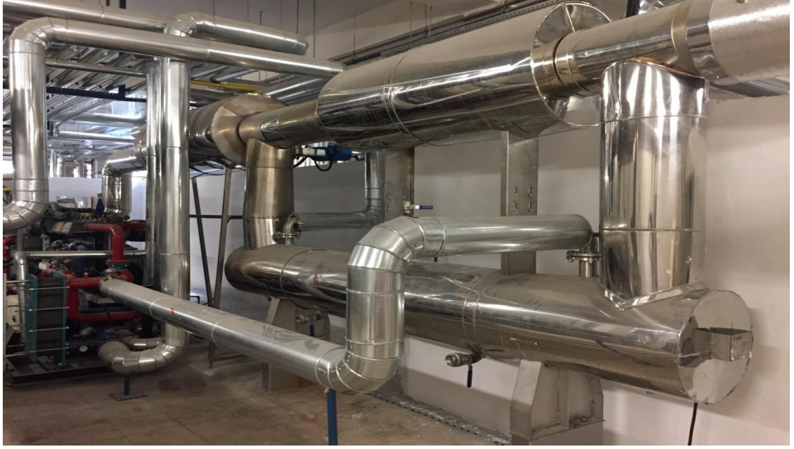
Şekil 3.13 Hastanede tesis edilen 275 kW gücündeki egzoz eşanjörü.
