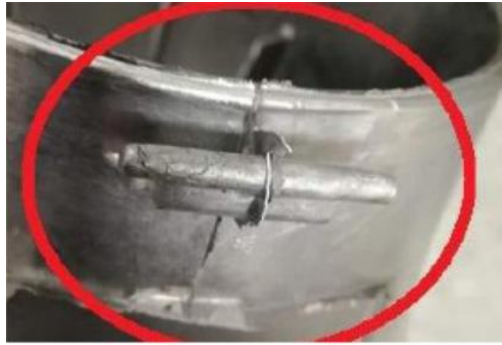
Şekil 3.18. Soğuk birleşme örneği (İştar, Şahin, Yıldırım ve Uygun, 2021)
