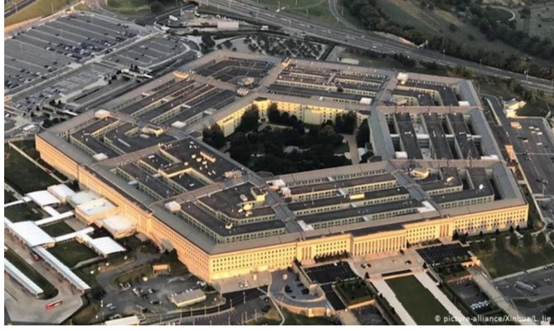
Şekil 3.21. Pentagon Binası Üstten Boşaltma Örneği (Zamanmühendisi, 2014).
