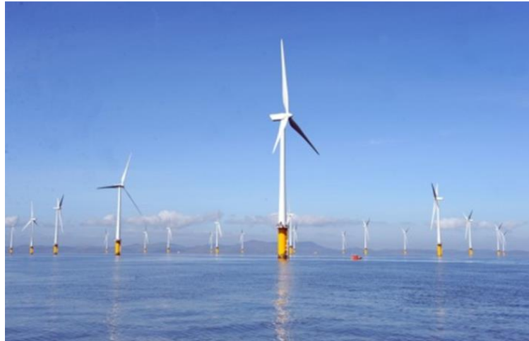
Şekil 2.27. London Array Deniz Üstü (off-shore) Rüzgar Santrali (Auswea, 2019).
