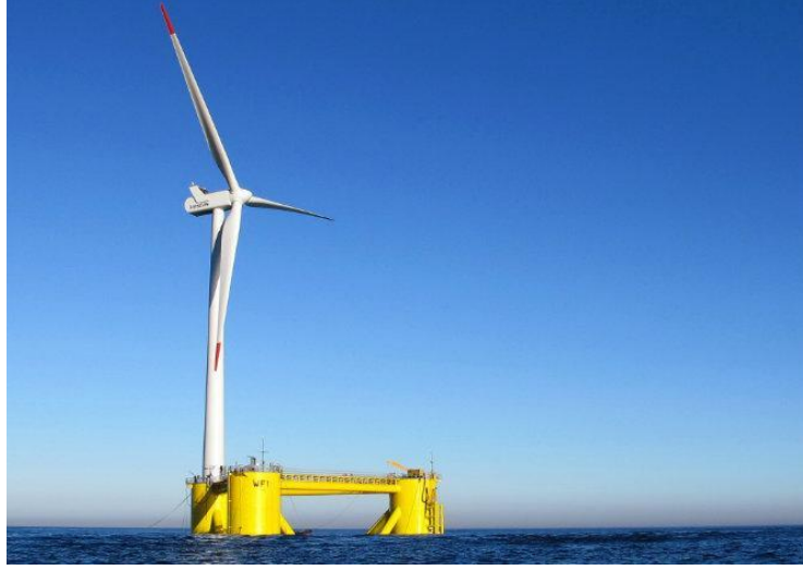
Şekil 2.28. Japonya Fukuşimada 2015 yılında Mitsubishi tarafından inşa edilen 7 MW'lık türbin (Çabuker, 2016).
