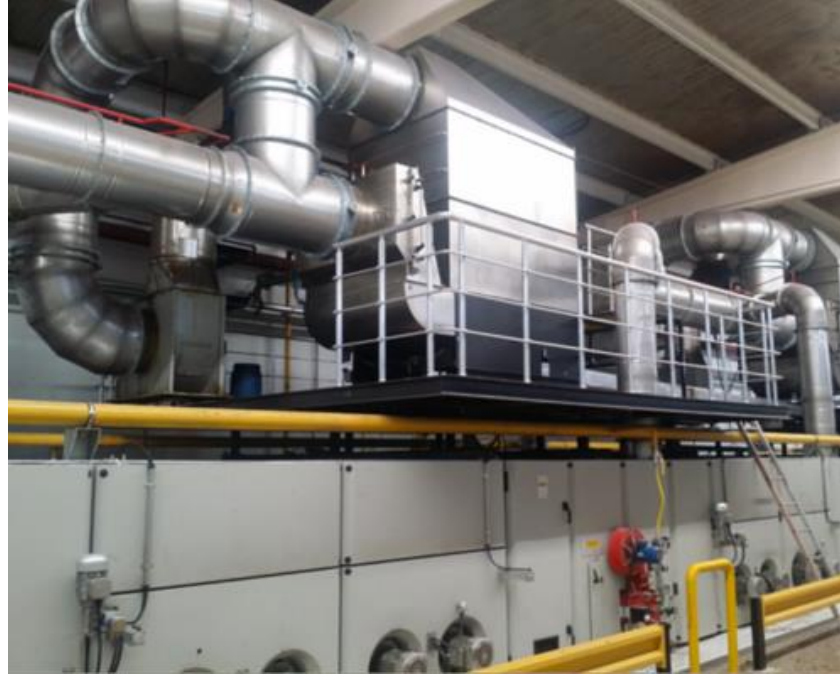
Şekil 7-6 Ramöz makinası üzerinde ekonomizer resmi
