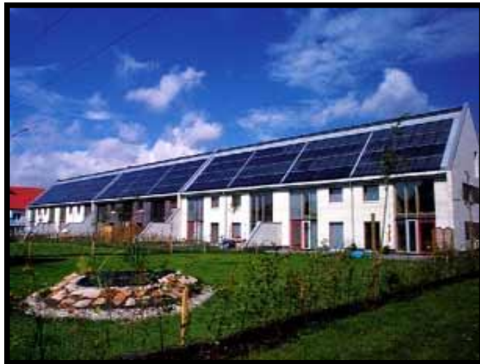
Şekil 4.5. Steinfurt-Borghorst Yerleşiminde Yer Alan Güneş Panelleri [39]
