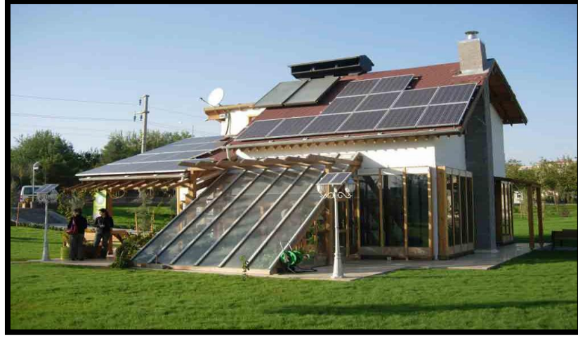
Şekil 4.11. Diyarbakır Güneş Evinde Yer Alan Trombe Duvarı [44]
