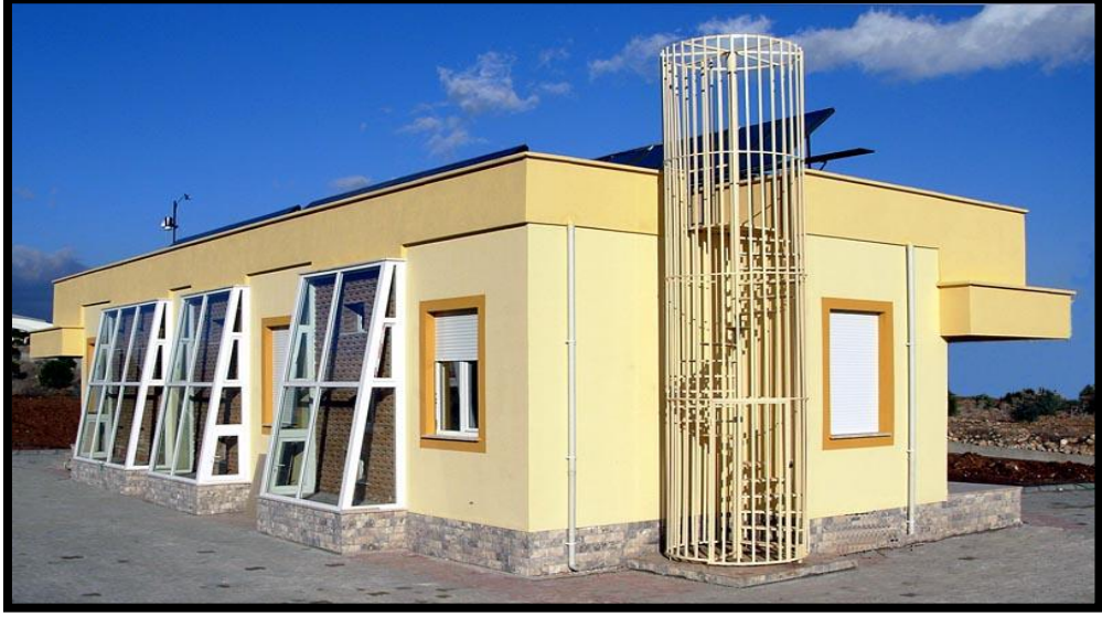
Şekil 4.18. Pamukkale Üniversitesi Güneş Evi Güney Cephesi-Trombe Duvarı [48]
