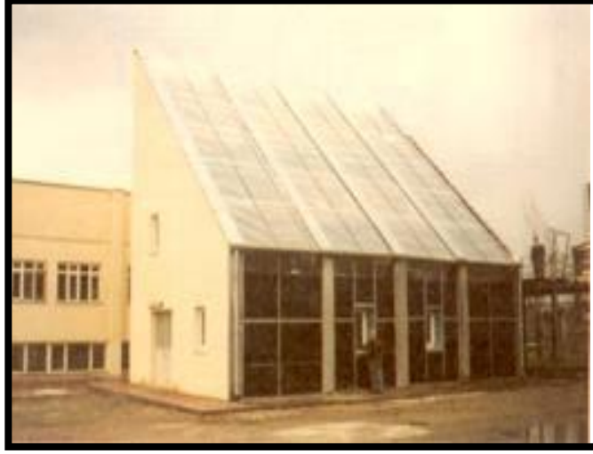
Şekil 4.17. Erciyes Üniversitesi Güneş Evinin Genel Görünüşü ve Yapıda Yer Alan Güneş Kolektörleri [47]
