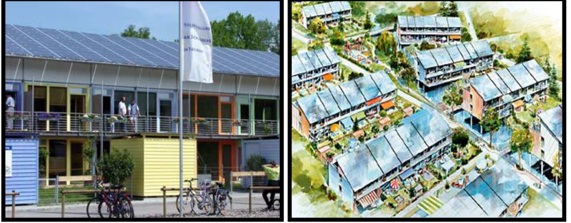
Şekil 4.1. Freiburg Riesenfild Yerleşiminin Çatısında Metal Taşıyıcılar Üzerine Tespit Edilen Çerçevesiz Güneş Pilleri [36]
