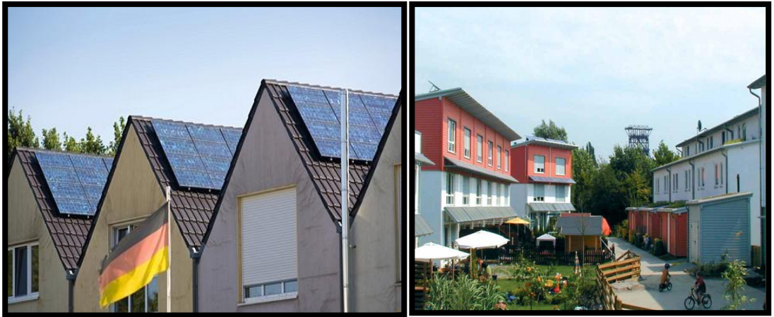
Şekil 4.2. Gelsenkirchen-Bismarck Güneş Yerleşiminde Çatıda ve Gölgeleme Elemanı Olarak Kullanılan Güneş Panelleri [36]
