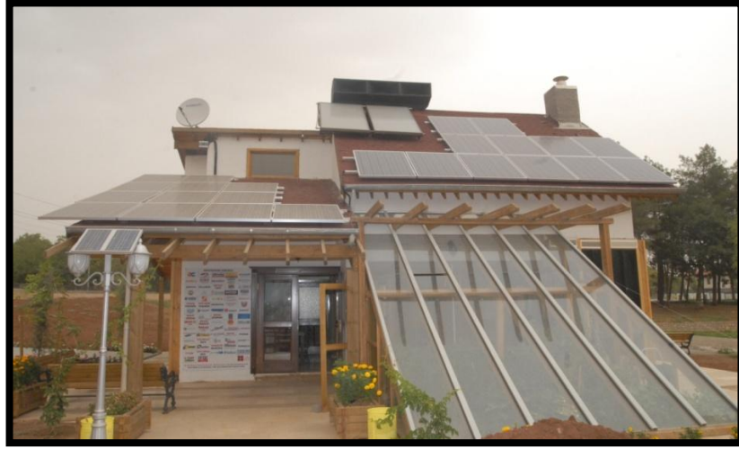
Şekil 4.12. Diyarbakır Güneş Evinde Güneş Panelleri ve Kış Bahçesi [44]
