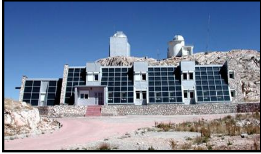
Şekil 4.13. TÜBİTAK Gözlemevinin Güney Cephesinden Görünüş [45]
