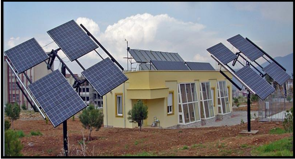
Şekil 4.19. Pamukkale Üniversitesi Güneş Evinde Yer Alan Sabit ve Hareketli Güneş Panelleri [48]
