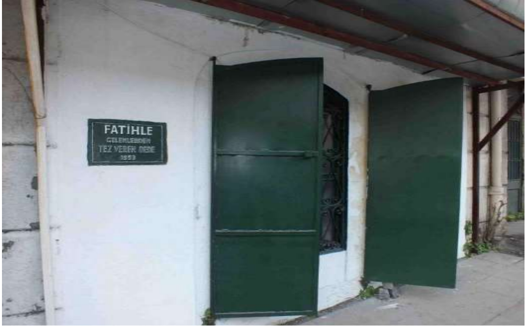
Fotoğraf 68: Tezveren Dede Türbesi. Apartman içerisinde bulunan türbe.
