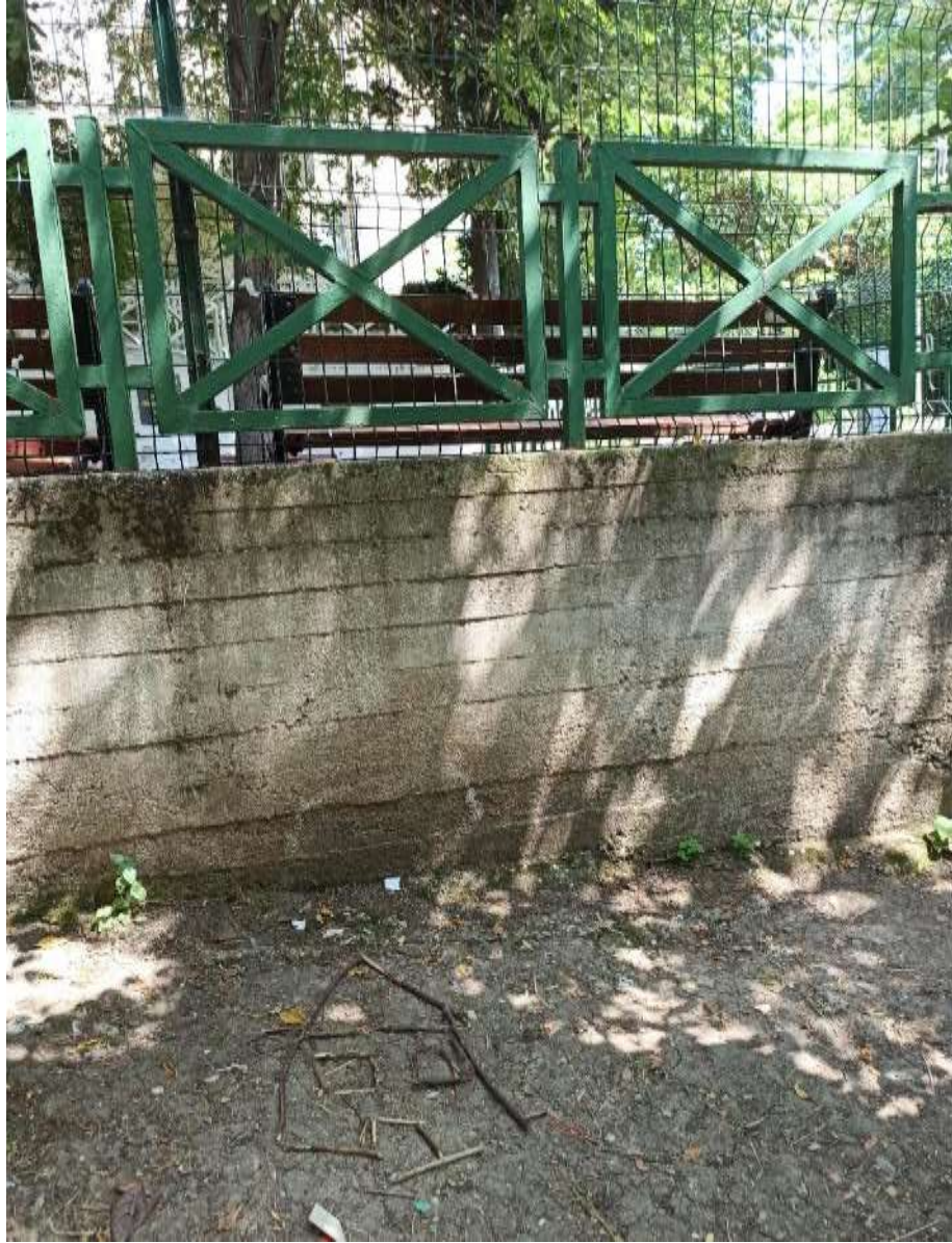
Fotoğraf 99: Zuhurat Baba Türbesi. Ađaç dallarından ev yapma adađı.
