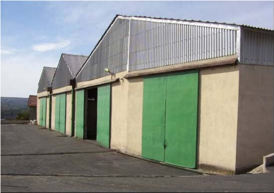
Şekil 3.1. Kapalı deponun genel görünüşü
