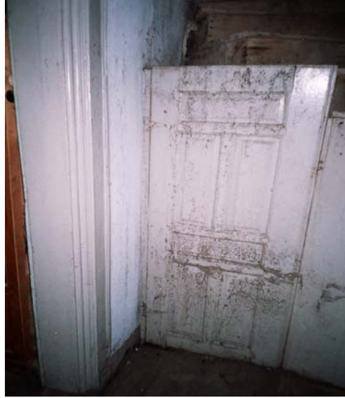
Resim B.18. Merdiven altı dolap kapısı
