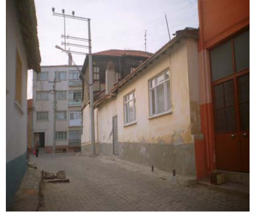
Resim A.15. Evin Sağ Yan Cephesi ve Müştemilatı
