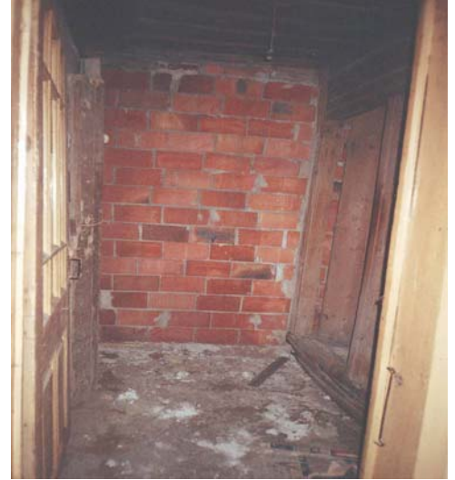
Resim B.6. W.c.Holüne Örülmüş Tuğla Duvar
