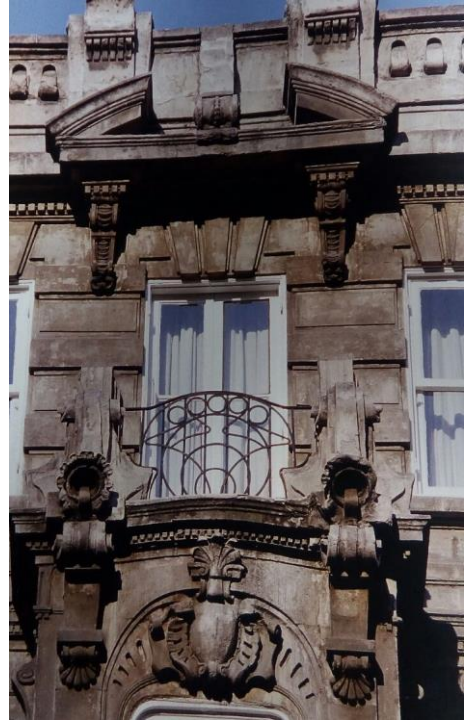
Resim 9: Osmanbey- Halaskargazi Cad. 208 No'lu Apartmanın Balkonu
