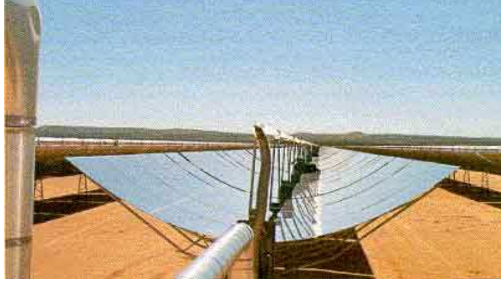
Şekil 3.2. Doğrusal yoğunlaştırıcı toplayıcı (EİE, 2006).
